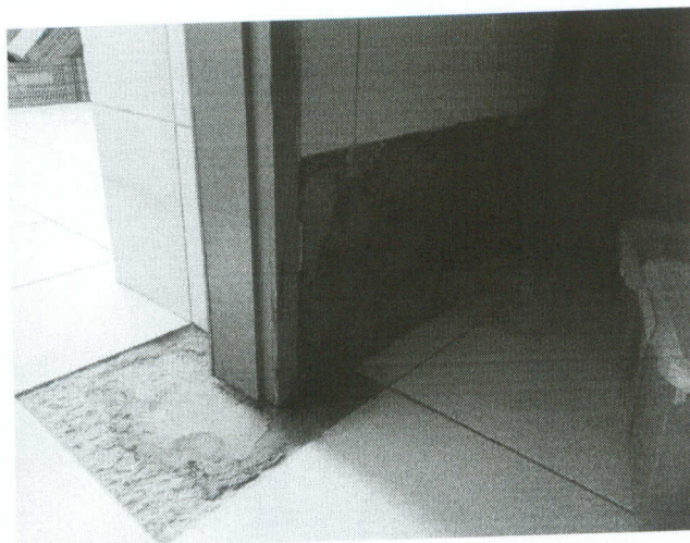
Murilo Amaral (parte do piso e parede sem revestimento)
