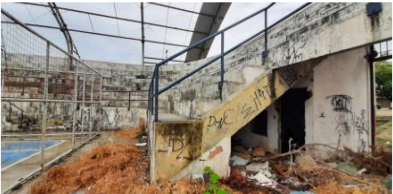
Figura 2: Detalhes das alvenarias, estrutura metálica e esquadrias verificados em visita técnica.
