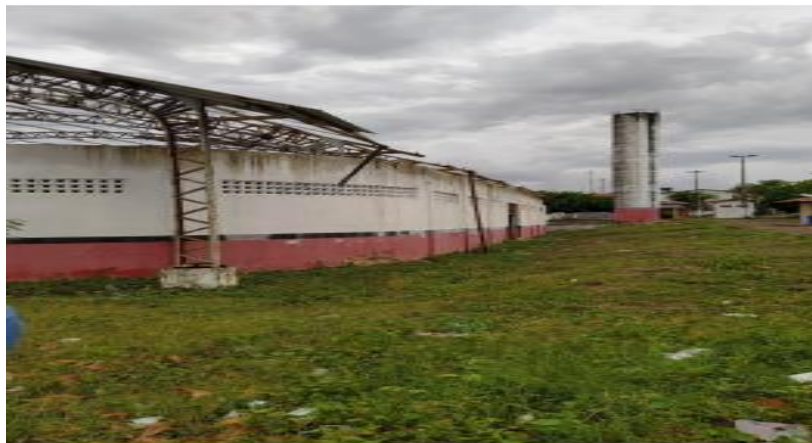
Figura 3: Canteiro em talude no entorno imediato de todo o ginásio.
