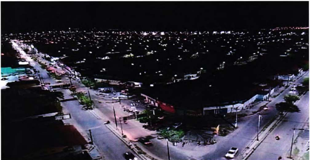
Avenida Contorno Norte - Iluminação de LED – Caucaia/CE
